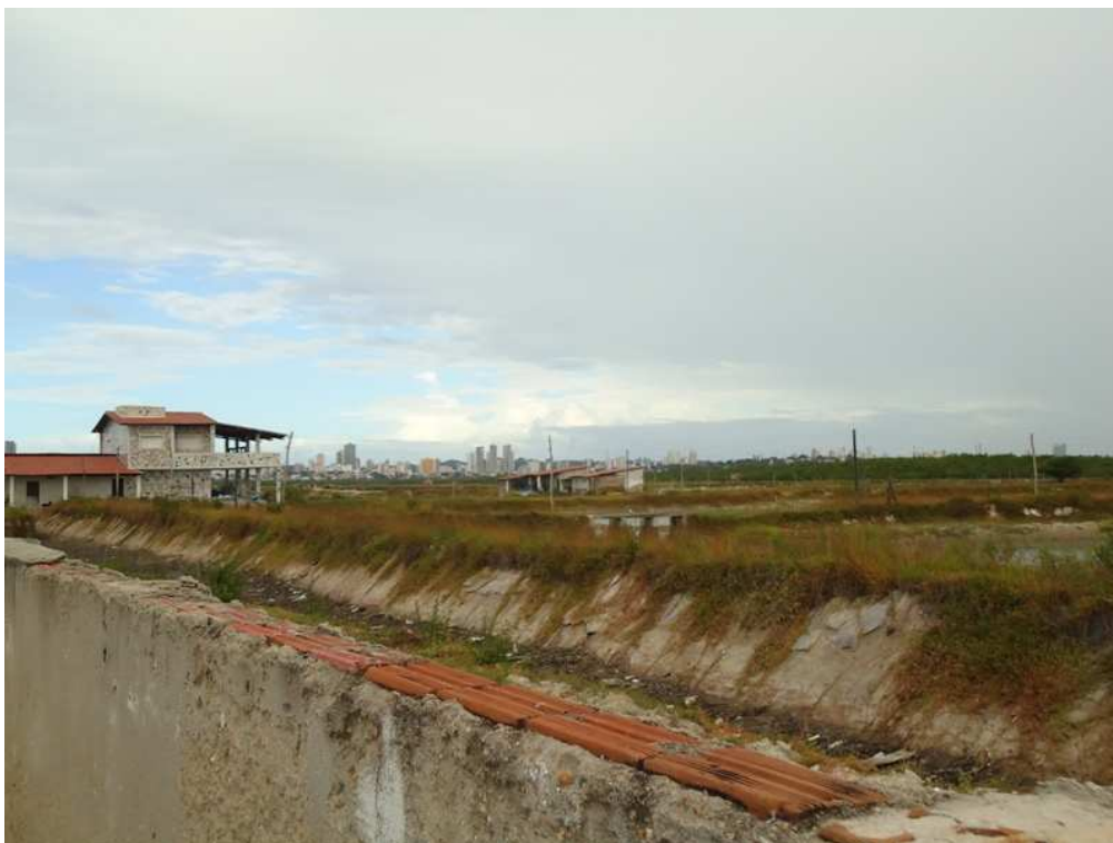
Ilustração 32: Obras de manutenção nos viveiros. Arquivo IBAM;SEMURB, 2010.
