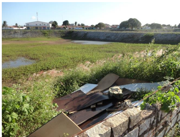
Figura 54. Lagoas de captação com vegetação e a presença de resíduos sólidos em suas margens
