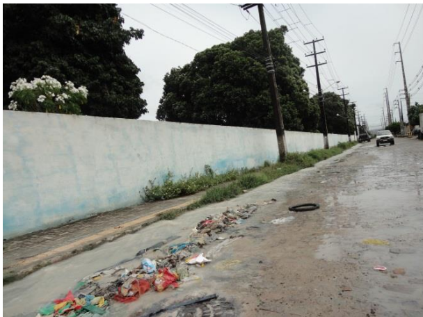
Figura 52. Grande quantidade de resíduos sólidos sendo carreados no escoamento de água pluvial
