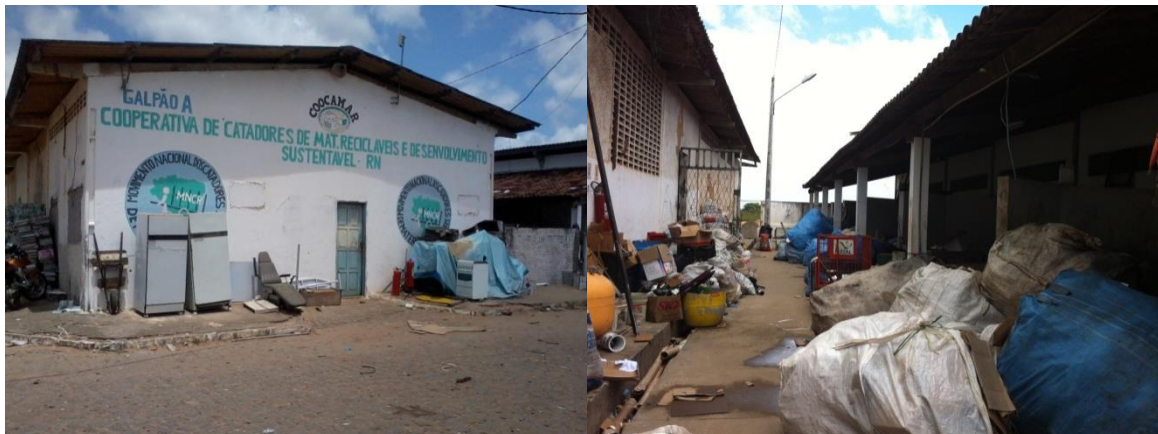
Figura 66. Galpão A – Cooperativa COOCAMAR Figura 67. Baias com materiais reciclados
