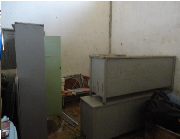
Figura 78. Vestiário improvisado, falta de estruturas físicas para o desenvolvimento do trabalho
