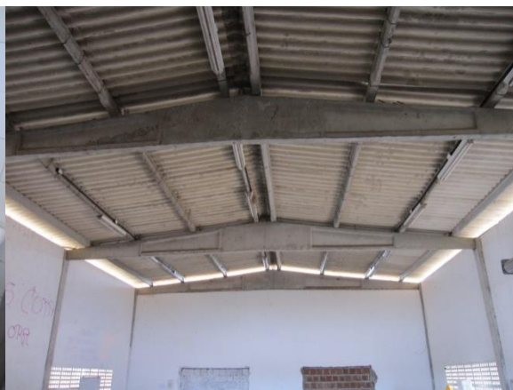
Figura 69. Estrutura do telhado e iluminação
