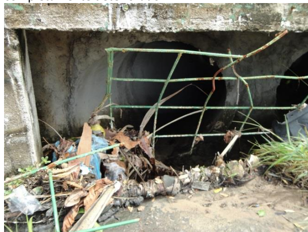
Figura 53 – Resíduos sólidos nos dispositivos de drenagem. Detalhe do gradeamento do dispositivo completamente deteriorado
