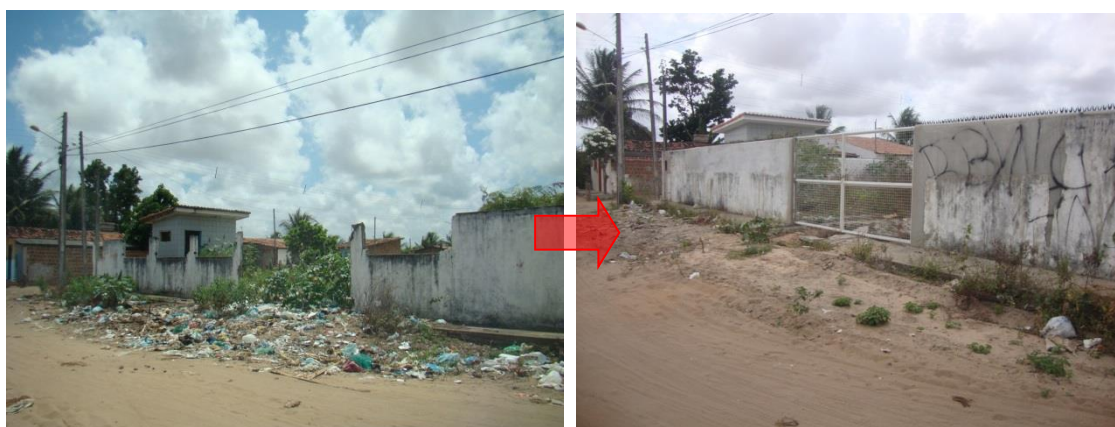
Figura 94. Extinção de Ponto de Deposição com a construção de muro
