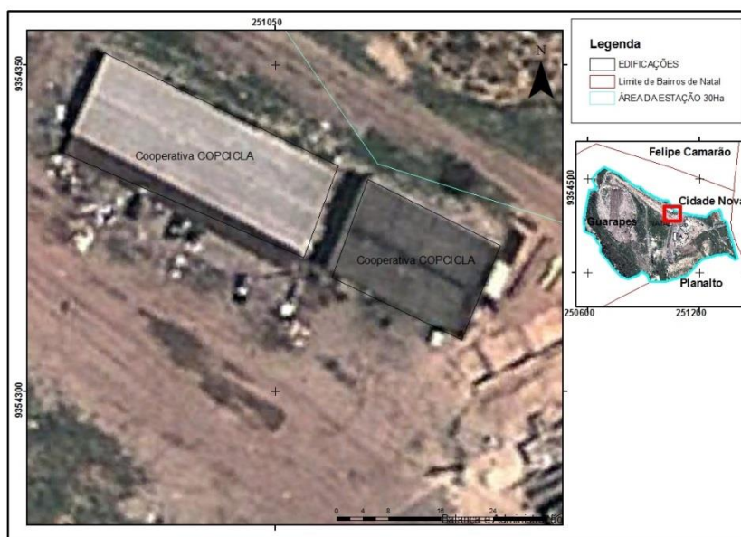
Figura 59. Galpões da Coopicla na Estação de Transbordo Provisória
