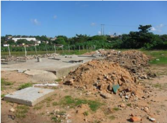
Figura 36. ETE do Bairro Nordeste, onde verifica-se a disposição de resíduos da construção civil (RCC).
