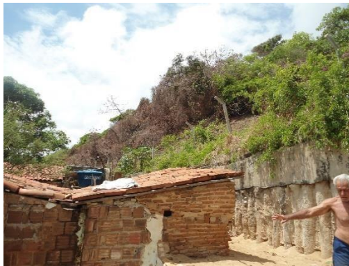
Figura 20. Muro de arrimo construído limitando o Parque Estadual Dunas do Natal e a comunidade de Mãe Luiza.
