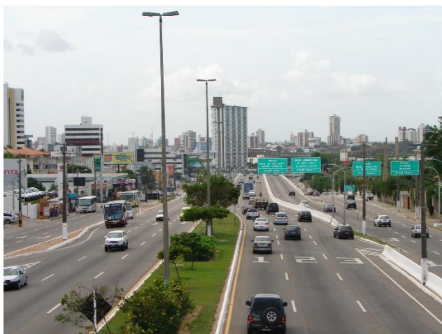
Figura 105. Visualização da vegetação do canteiro central do trecho urbano da BR 101, no município de Natal
