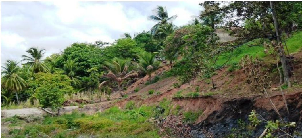
Figura 45. Erosão em vertentes de tabuleiro da ZPA-08 com alto risco e intenso processo erosivo já instalado
