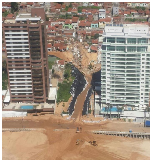
Figura 67. Imagem aérea da resultante do movimento de massa por deslizamento ocorrido na Rua Guanabara, no bairro de Mãe Luiza.
