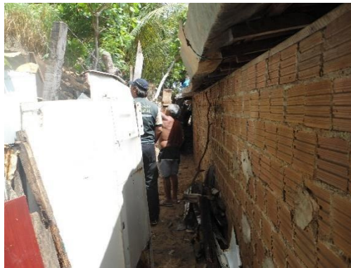
Figura 21. Acesso aos fundos da Residência de nº 304
