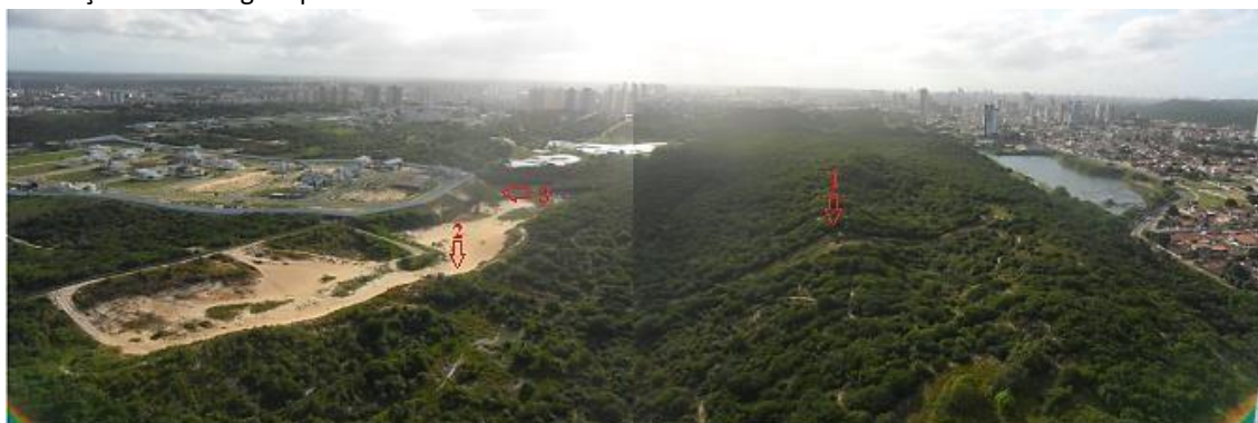
Figura 29. Visão aérea da ZPA-05, situação do entorno e reservatórios de detenção (RD). Ponto 1 (P1) tubulação de drenagem para reservatório
