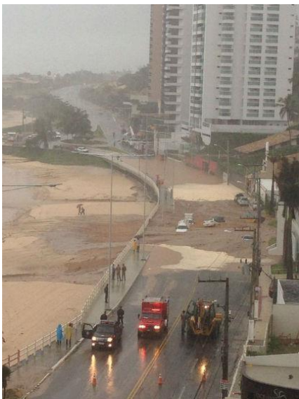
Figura 66. Imagem aérea da resultante do movimento de massa por deslizamento ocorrido na Rua Guanabara, no bairro de Mãe Luiza.
