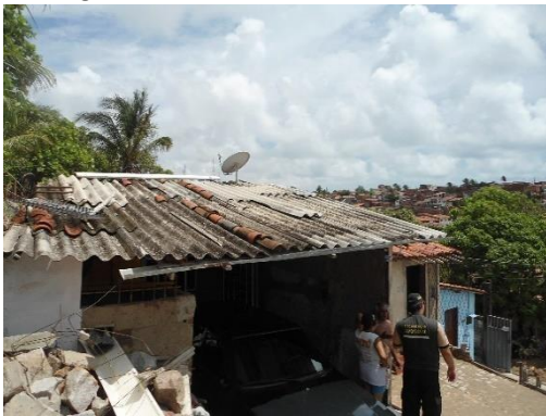
Figura 18. Residências situadas na encosta das dunas na margem direita da VIII Travessa João XXIII.
